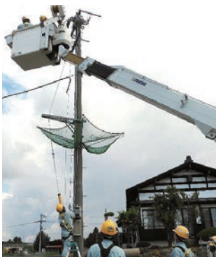
▲実技の部 PAS の揚替えとポールネットの役割その取付方を学びました。
