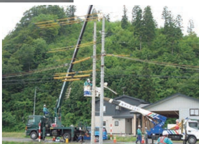
<穴掘建柱車>使用の様子
