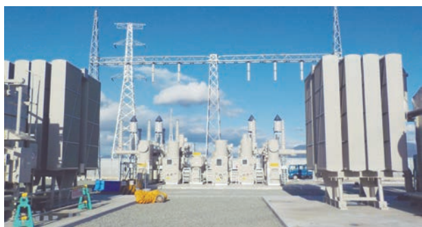
発電電作業現場
