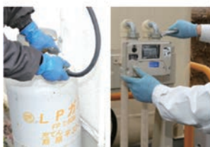
LPガス・灯油機器の施設工事
