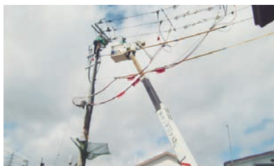
高所作業の様子
