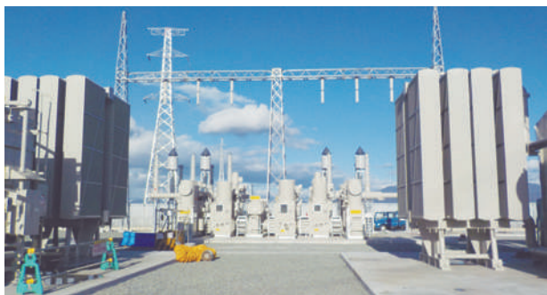
発電電作業現場
