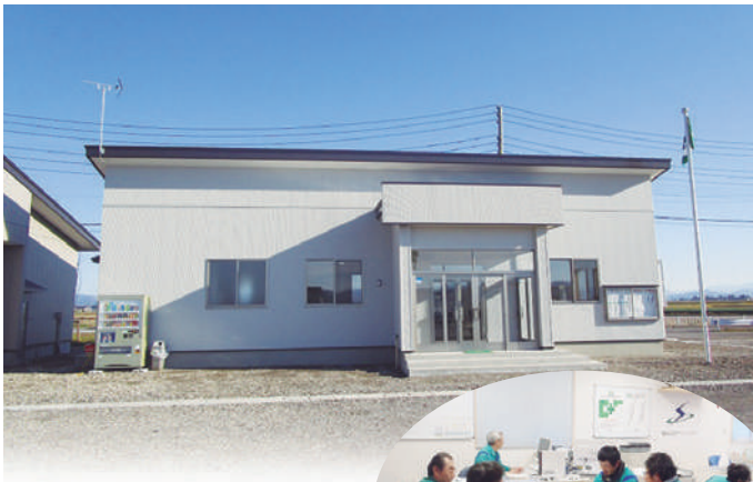
配電部事務所
