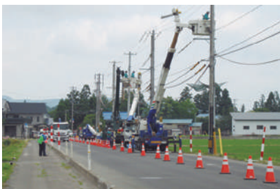
<高所作業車>使用の様子
