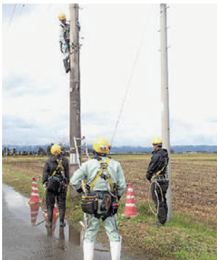
▲引込線工事の為の昇降訓練
