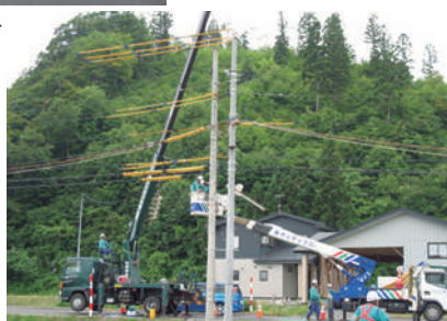
<穴掘建柱車>使用の様子
