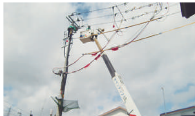
高所作業の様子
