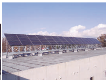
▲当社施工 横手市立平鹿中学校 再生可能エネルギー等導入工事 （太陽光発電設備）
