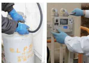
LPガス・灯油機器の施設工事
